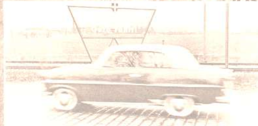
Hier - auf dem noch freien Feld - soll das große Expressstraßen-Kleeblatt mit seinen Abzweigungen entstehen (oben links).
